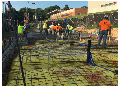
FD- Slab on Grade Concrete Pour
